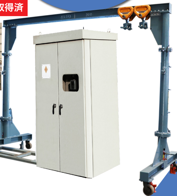
④据付位置に移動しアイボルトと門型クレーンを外し据付ます
