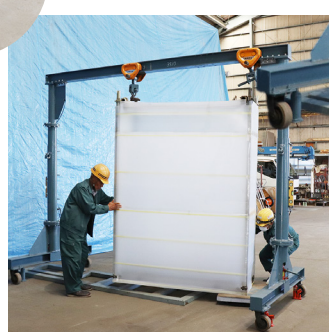
②ジャッキで調整しながら配電盤と門型クレーンをアイボルトで繋ぎます
