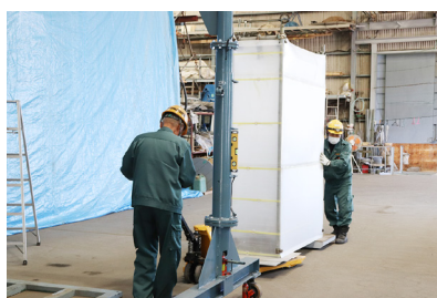
①配電盤をターンテーブルや自由移動台車に乗せ移動
