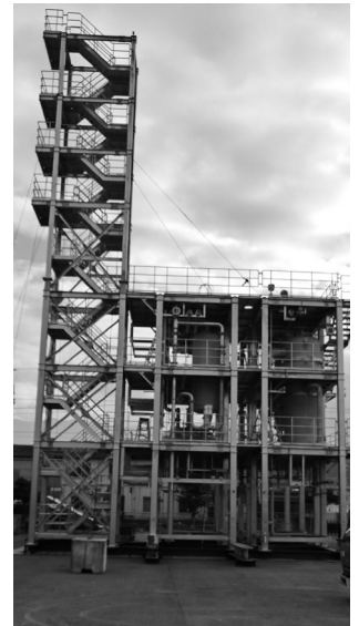
国内某所向け アンモニア回収設備 ユニット製作・組立
