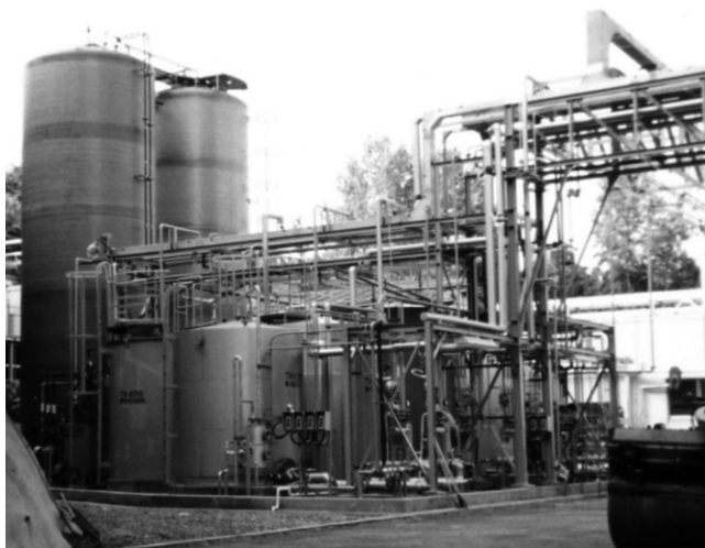
プラント建設工事
